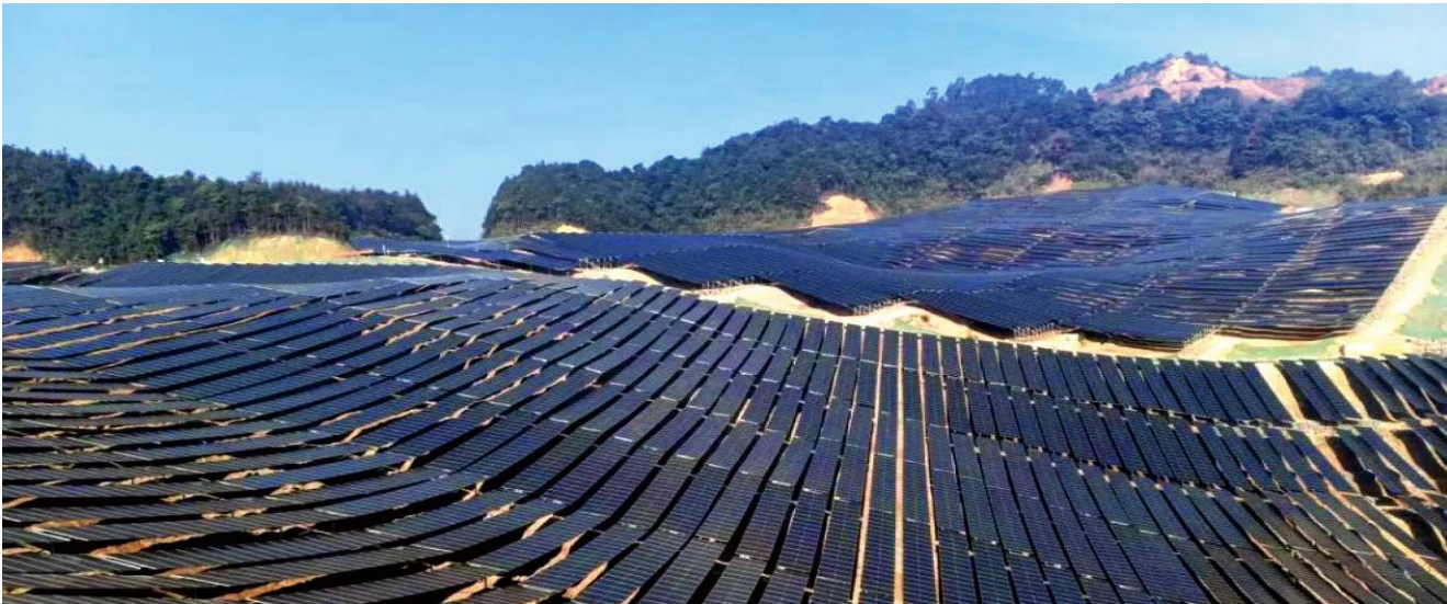
100MW 天镇县100MW 光伏发电+10%储能项目
