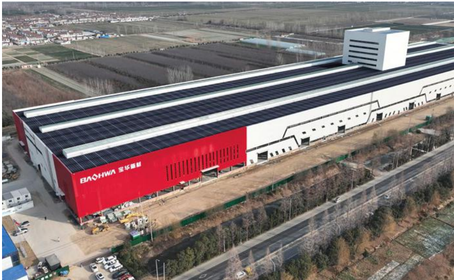
3MW 宝华金属材料3MW光伏BIPV项目
