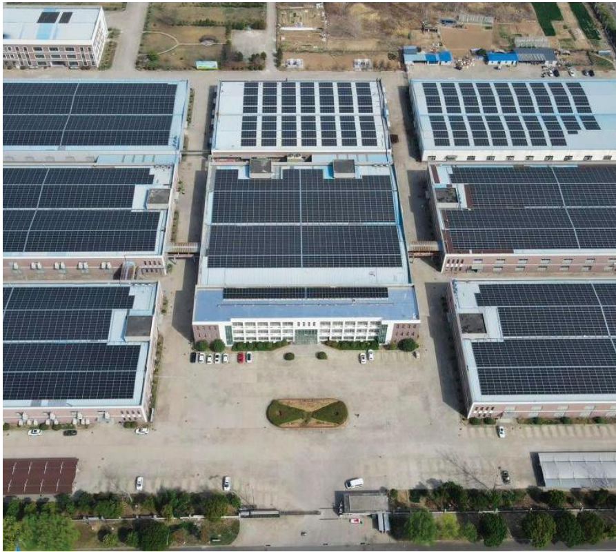
6MW 淮安中哲实业6MW屋顶分布式光伏发电项目
